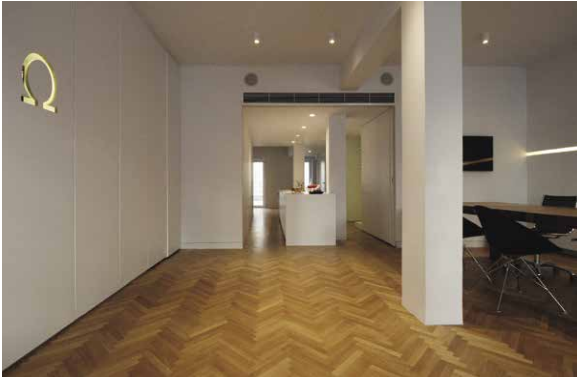
Οικία στο Κολωνάκι (Η ανακαίνιση βρίσκεται σε εξέλιξη)
